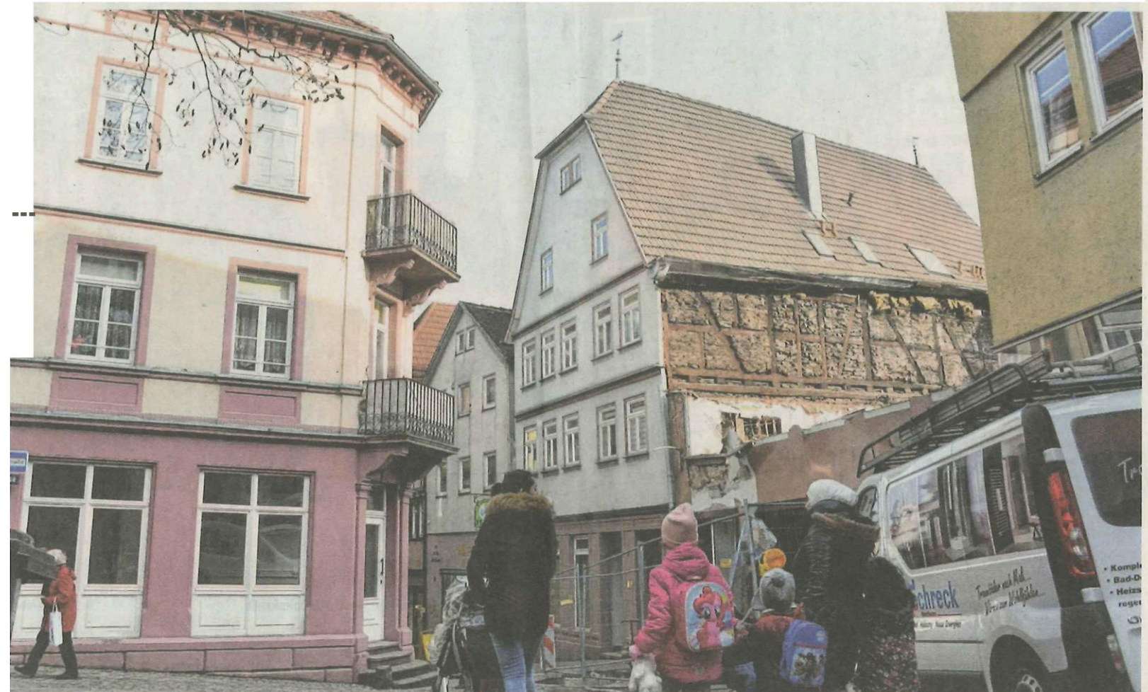
Das Gebäude des ehemaligen Mainkaufhauses beziehungsweise des Gasthauses „Zum Engel“ gehört der Geschichte an. Die Abrissarbeiten laufen.
